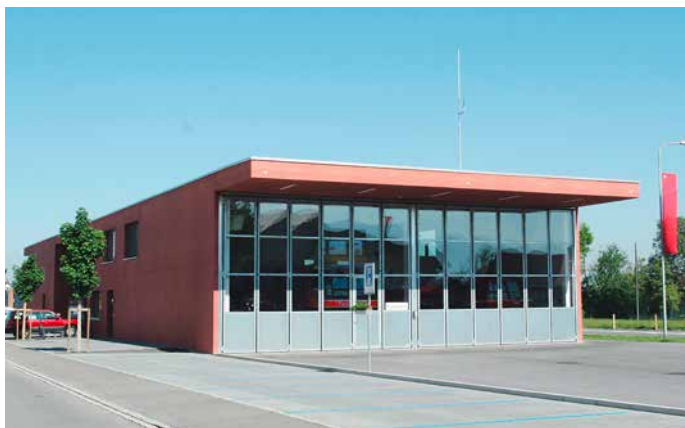
Feuerwehr- und Werkhofgebäude im Tischmacherhof, Galgenen
