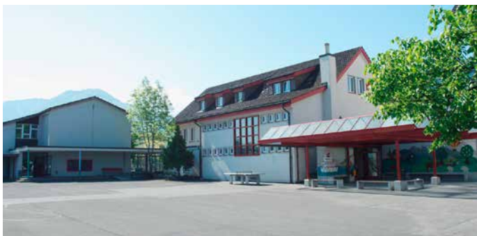
Schulhaus Dorf, Galgenen
