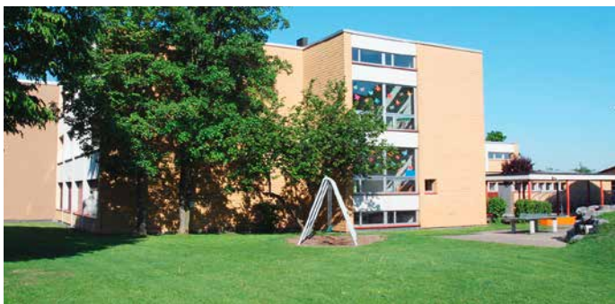
Schulhaus Büel in Siebnen-Galgenen
